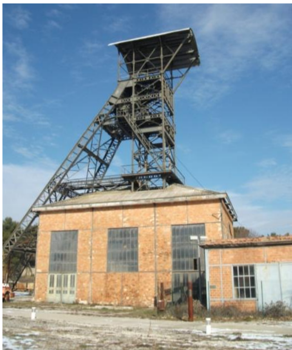
Puits Hély d'Oissel
