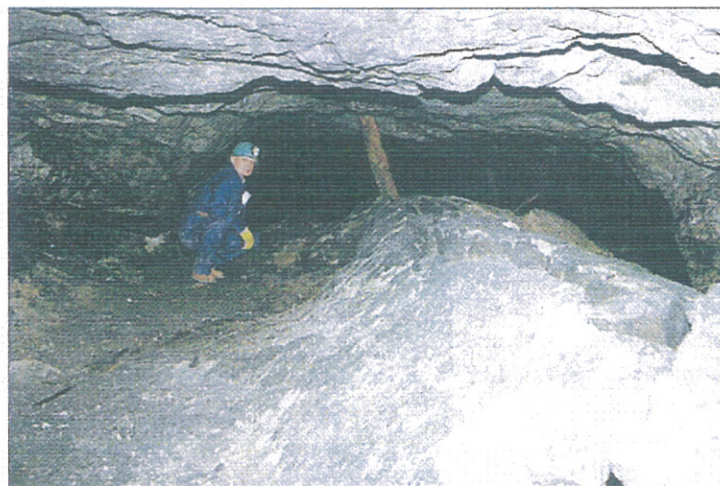
Photo n°3 - Soufflage du mur : Guide technique "cavités souterraines"
